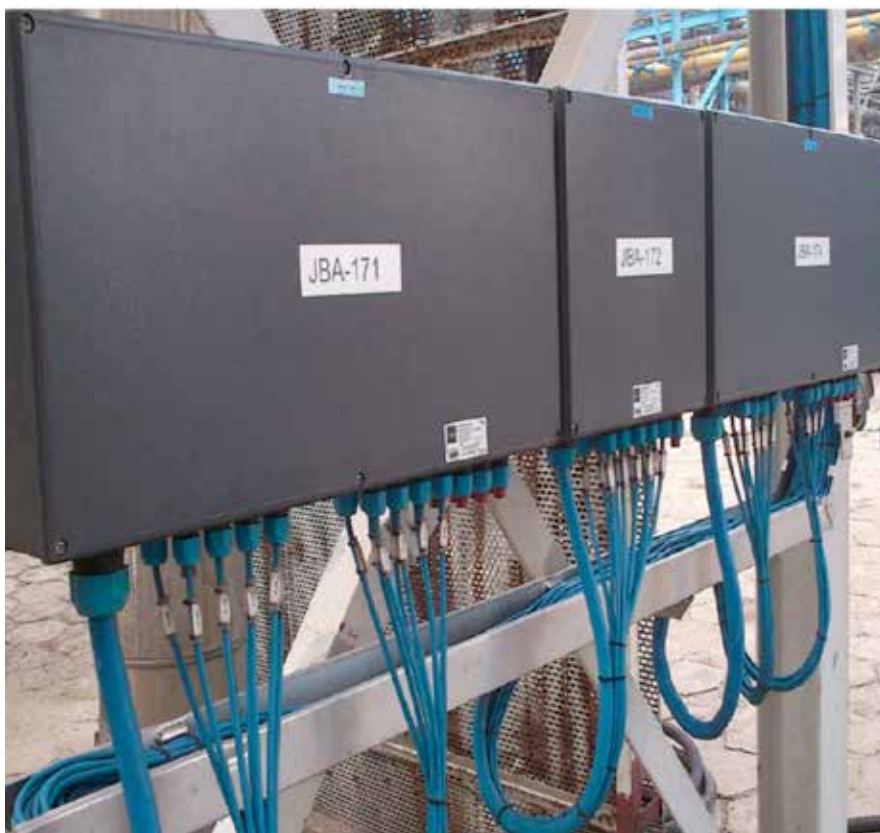
Wydział syntezy amoniaku – Grupa Azoty PUŁAWY. Strefa zagrożenia wybuchem – zastosowanie przewodów IB-BiT 500°C
